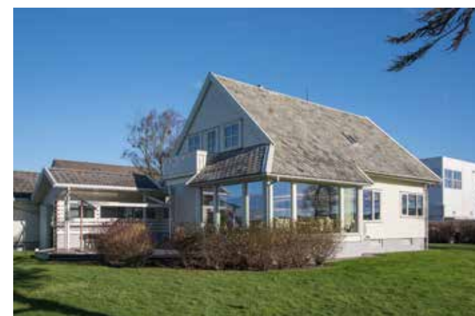
Rehabilitering lønner seg. Dette huset fikk nye energieffektive vinduer og lys, trivelig stue.
